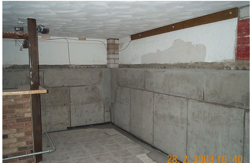
Abbildung 2: Sicherheit ist planbar und wird durch stringente Umsetzung und Bauüberwachung gewährleistet
